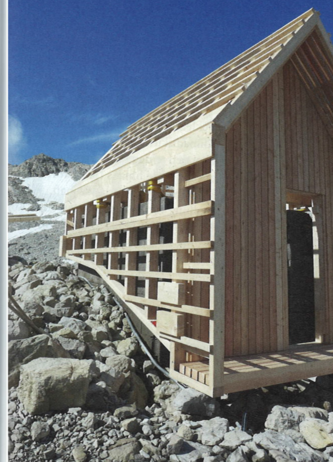
... kommen: Der Standort der kleinen Hütte liegt auf 2600 m Höhe
