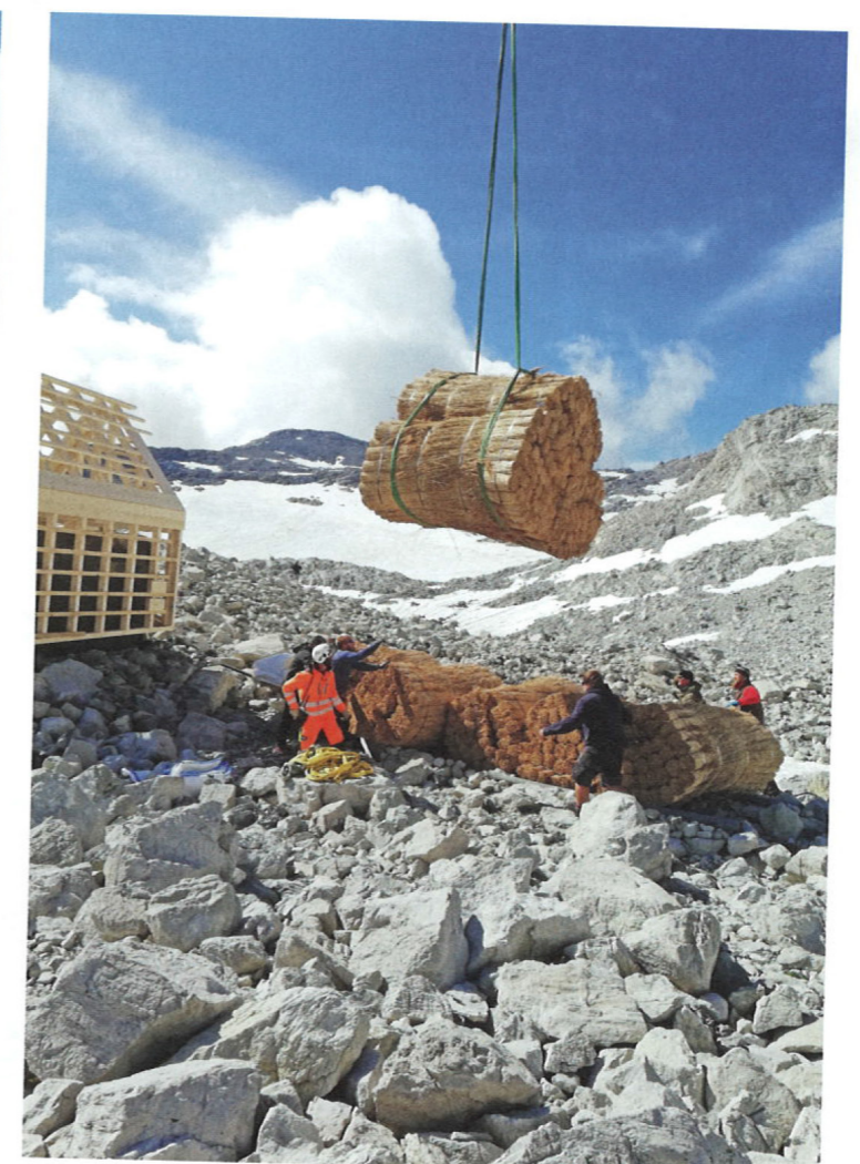
▲ Unter anderem flogen 1100 Reetbunde am Tragseil zur alpinen Baustelle
