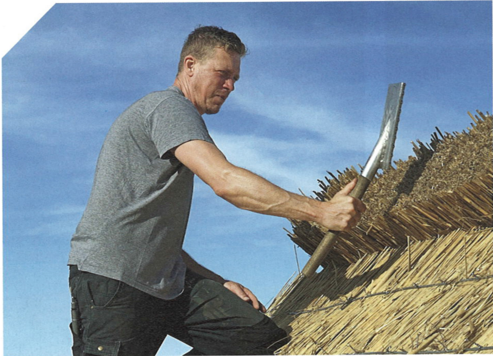
▲ Abenteurer in den Bergen: Reetdachdecker Marco Weichert bei der Arbeit an der »Forschungshütte«
