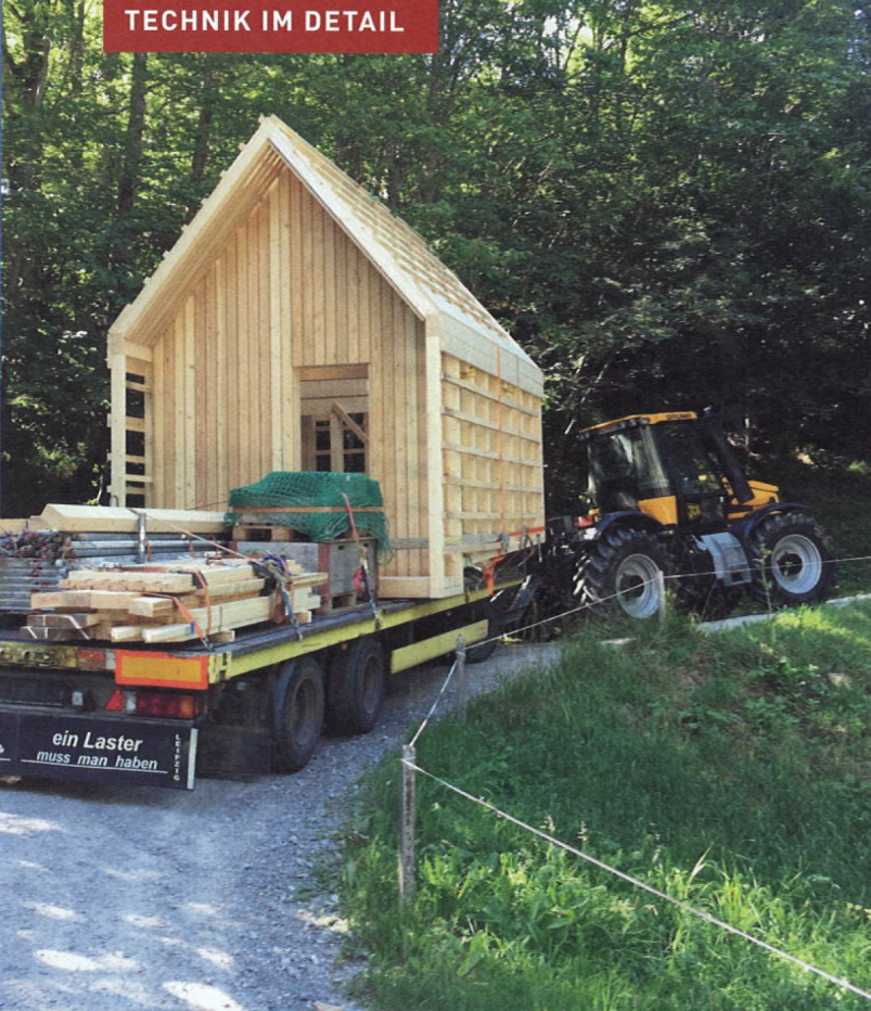
▲ Auf Reisen: Der Holzrohbau der Hütte wurde zunächst mit dem Tieflader ...
