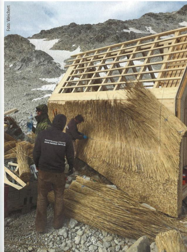
Das Reet wurde Bund für Bund mit den klassischen und modernen Werkzeugen der Reetdachdecker auf dem Dach und an der Fassade verlegt.
