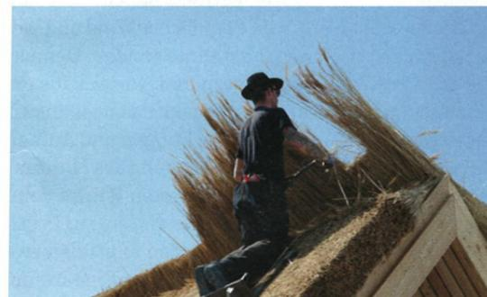
Die Reetdachdecker der Weichert GmbH aus Berlin haben das Dach und die Fassade der Berghütte mit Reet eingedeckt
