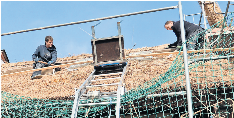
An der Südseite des Reetdachs arbeiten Torsten Göhlith (l.) und Marko Dartscht vom Unternehmen Weichert Reetbedachungen & Ökobau noch.
