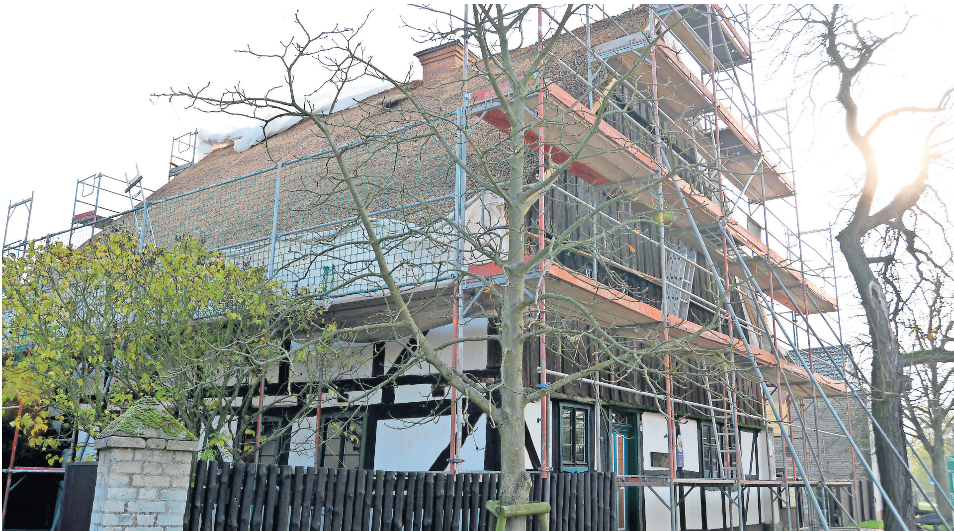
Die Nordseite des neuen Reetdachs auf dem Bauernmuseum Blankensee ist bereits fertiggestellt.
