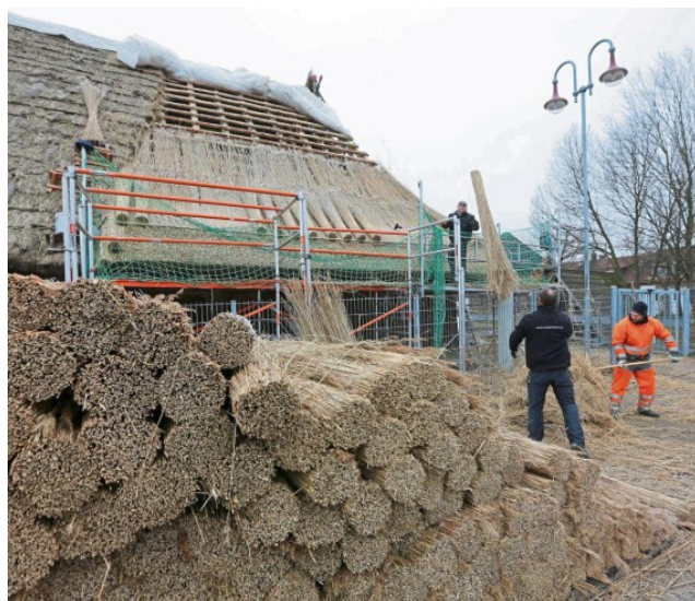
Hunderte Bündel Reet bilden die neue Bedeckung des Hochdorfer Keltenhauses an Stelle des alten Roggenstrohs (links auf dem Dach). Fotos: Küppers
