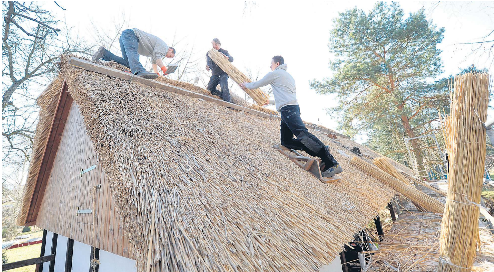
Liegt das Schilfrohr perfekt, bleibt das Dach 50 Jahre dicht. Auch auf diesem Gartenhaus in Geltow (Potsdam-Mittelmark).
